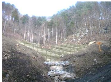
建設工事(治山) 間伐材を利用した谷止工(中身は石)
