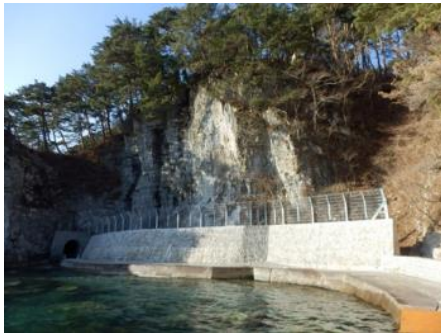
浄土ヶ浜遊歩道の復旧工事 国立公園内のため、景観を損ね ないように落石対策を行う
