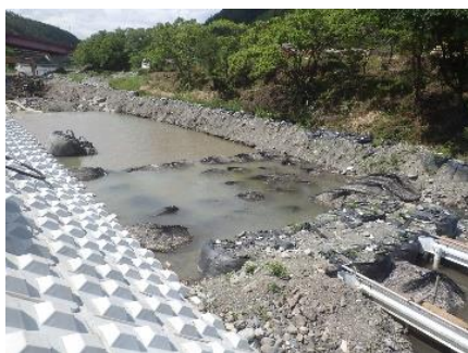
カキ殻を利用した掘削時の汚濁処理
