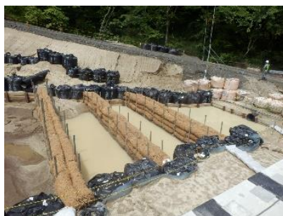
ヤシ繊維を利用した掘削時の汚水処理
